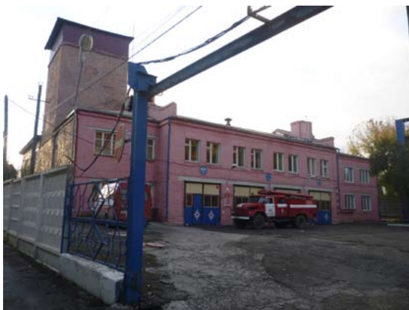
Рис. 28. Пожарное депо (фото 2012 г.)
