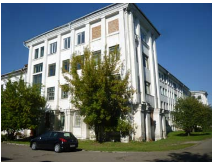
Рис. 10. Здание Краевой больницы (фото 2012 г.)
