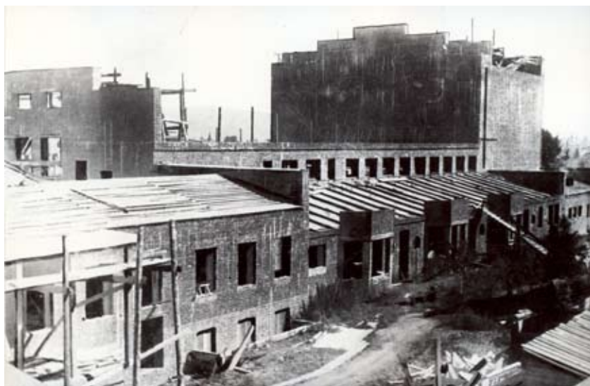
Рис. 3. Строительство клуба железнодорожников – 1930-е гг.
