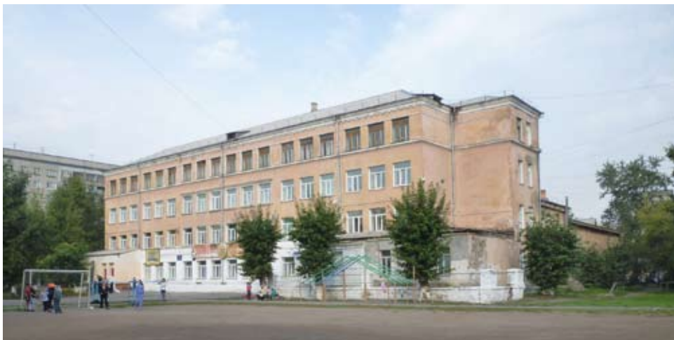
Рис. 19. Здание общеобразовательной школы на ул. Горького (фото 2012 г.)
